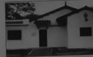
Fachada del edificio
